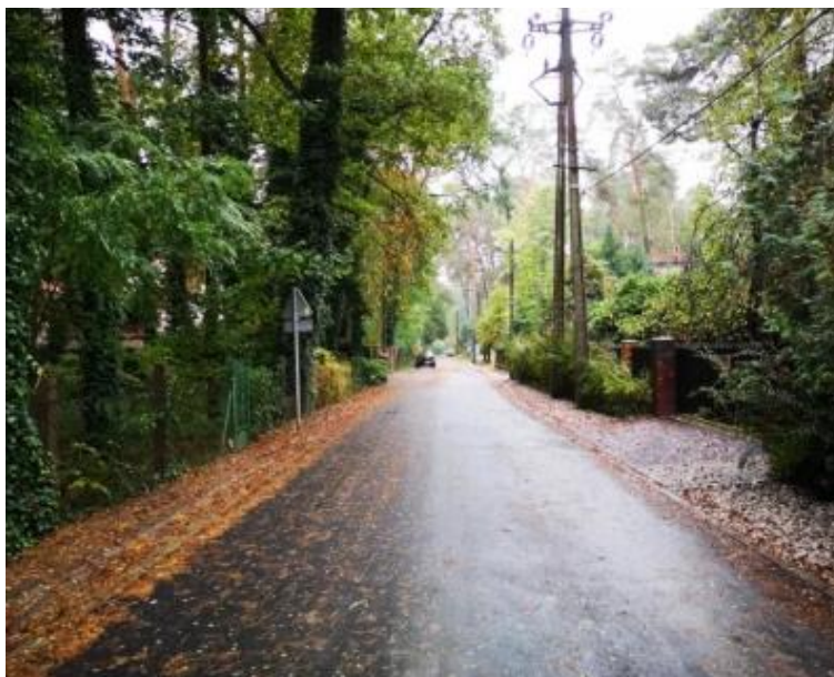
Rysunek 9 Zmodernizowana ulica Sosnowa
