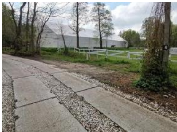
Rysunek 7 Zmodernizowana ul. Irysowa
