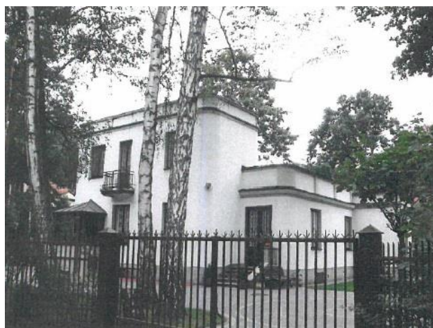
Fotografia 133. Willa przy ulicy Akacjowej (działka nr ewid. 15, obręb 12)
