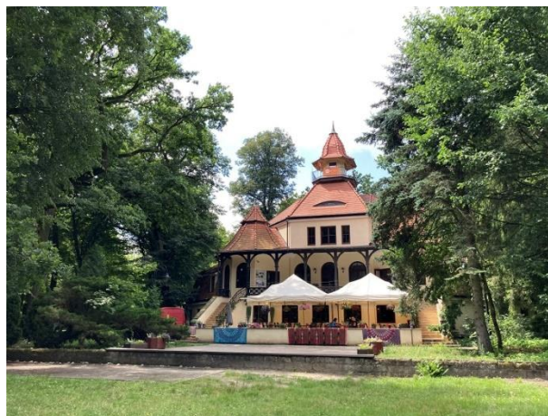
Fotografia 59. Pałacyk Kasyno Fotografia własna
