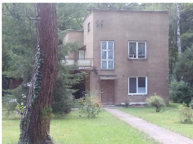
Fotografia 114. Dom przy ulicy Iwazkiewiczza (działka nr ewid. 9, obręb 7)
