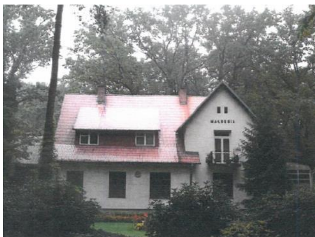
Fotografia 75. Willa Małgosia przy ulicy Słowiczej (działka nr ewid. 198, obręb 2)
