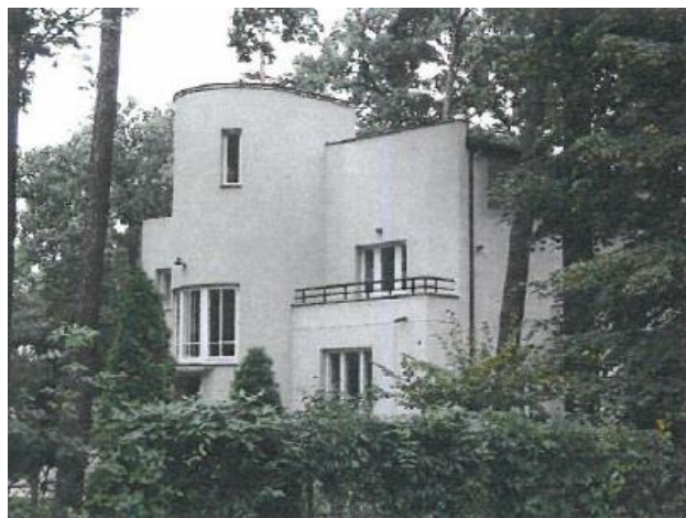
Fotografia 127. Willa przy ulicy Sienkiewicza (działka nr ewid. 23, obręb 10)
