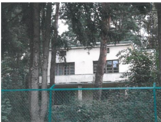
Fotografia 109. Willa przy ulicy Iwazkiewicza (działka nr ewid. 22, obręb 7)
