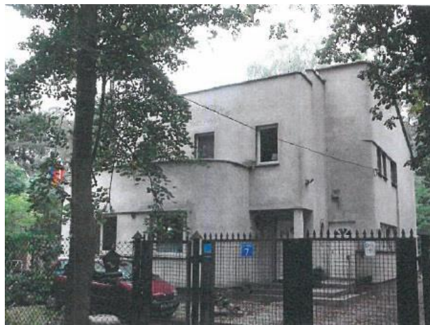
Fotografia 125. Willa Stokrotka przy ulicy Jaworowej (działka nr ewid. 101, obręb 11)
