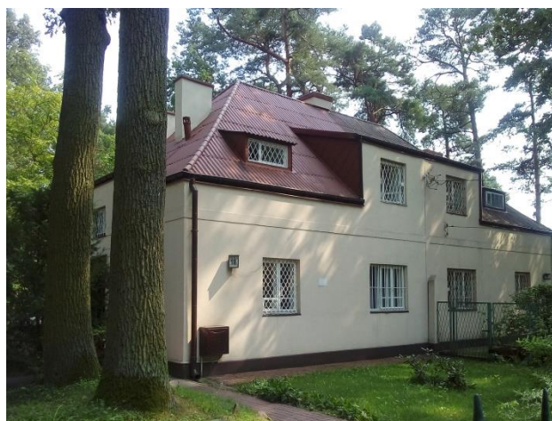
Fotografia 212. Dom jednorodzinny przy ulicy Mickiewicza (działka nr ewid. 121, obręb 10) Fotografia własna
