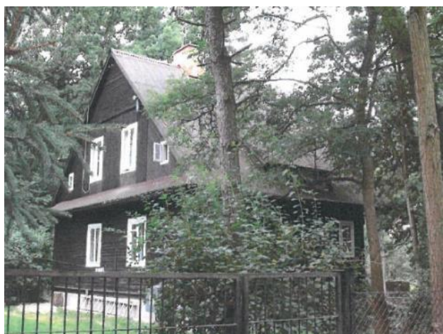
Fotografia 157. Dom przy ulicy Sosnowej (działka nr ewid. 191, obręb 12)
