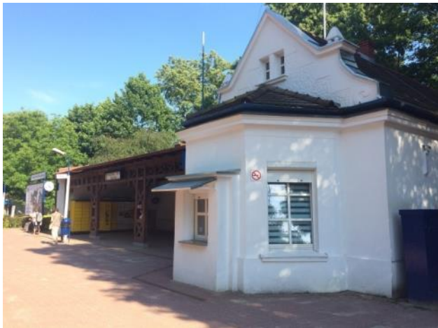
Fotografia 60. Budynek stacji WKD „Podkowa Leśna” Fotografia własna
