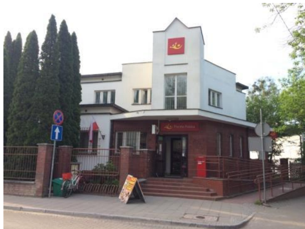
Fotografia 57. Budynek poczty – ulica Słowicza Fotografia własna
