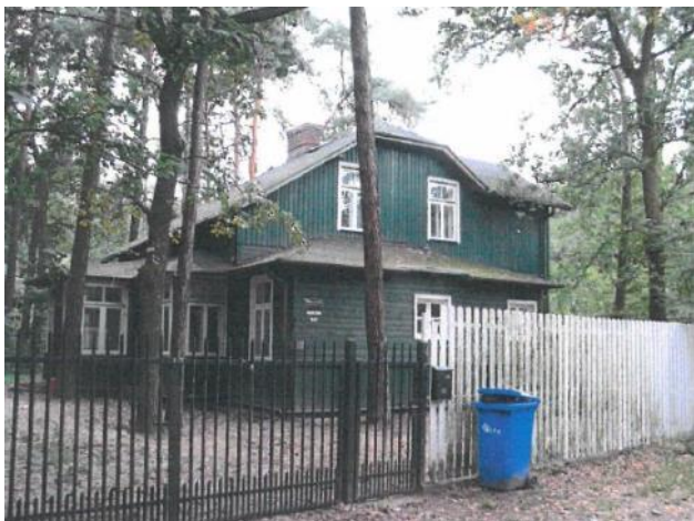
Fotografia 155. Dom przy ulicy Sosnowej (działka nr ewid. 84, obręb 12)
