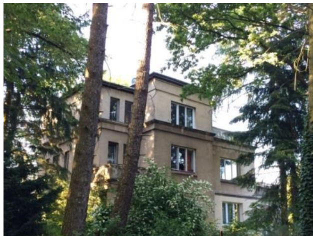
Fotografia 41. Zabudowa wielorodzinna – ulica Kościelna Fotografia własna
