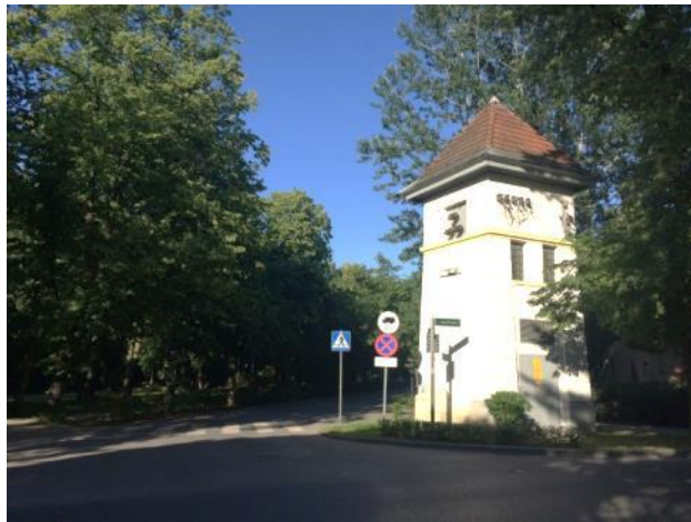
Fotografia 61. Stacja transformatorowa przy Jana Pawła II Fotografia własna
