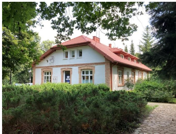
Fotografia 62. Budynek Urzędu Miasta Fotografia własna
