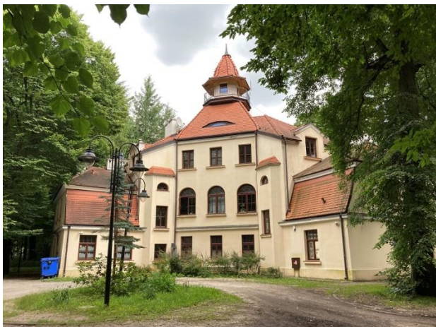
Fotografia 204. Pałacyk Kasyno Fotografia własna
