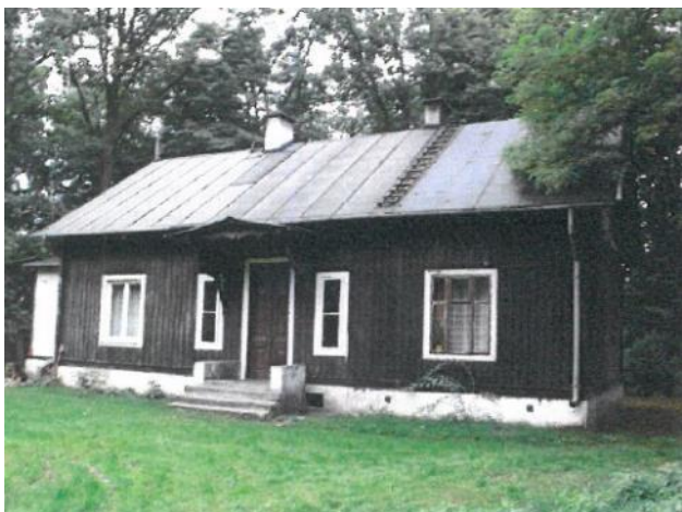
Fotografia 151. Dom przy ulicy Cichej (działka nr ewid. 239, obręb 12)
