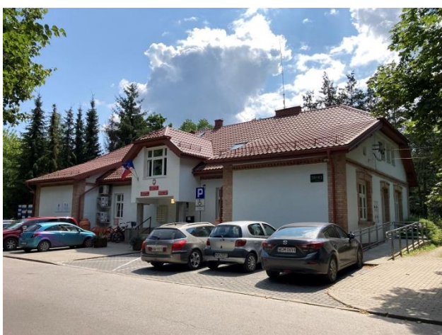
Fotografia 237. Budynek Urzędu Miasta Fotografia własna
