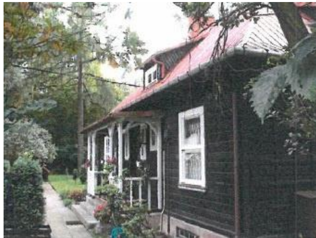
Fotografia 150. Dom przy ulicy Cichej (działka nr ewid. 110, obręb 12)
