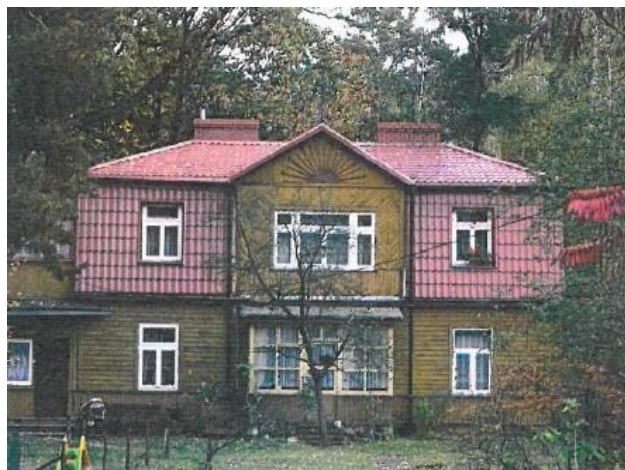
Fotografia 144. Dom przy ulicy Żeromskiego (działka nr ewid. 42, obręb 10)
