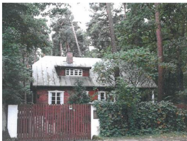
Fotografia 154. Dom przy ulicy Lilpopa (działka nr ewid. 36, obręb 8)
