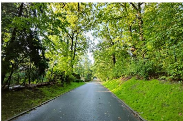
ul. Gołębia po remoncie
